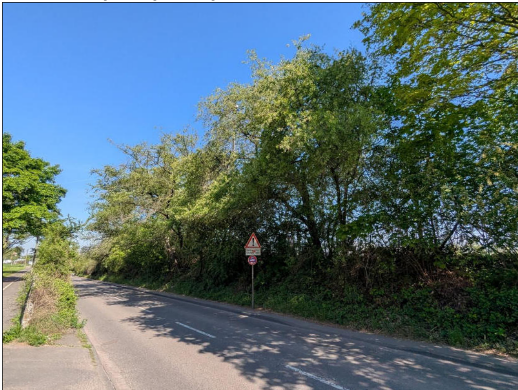
Abb. 3: Böschung entlang der Longericher Straße
