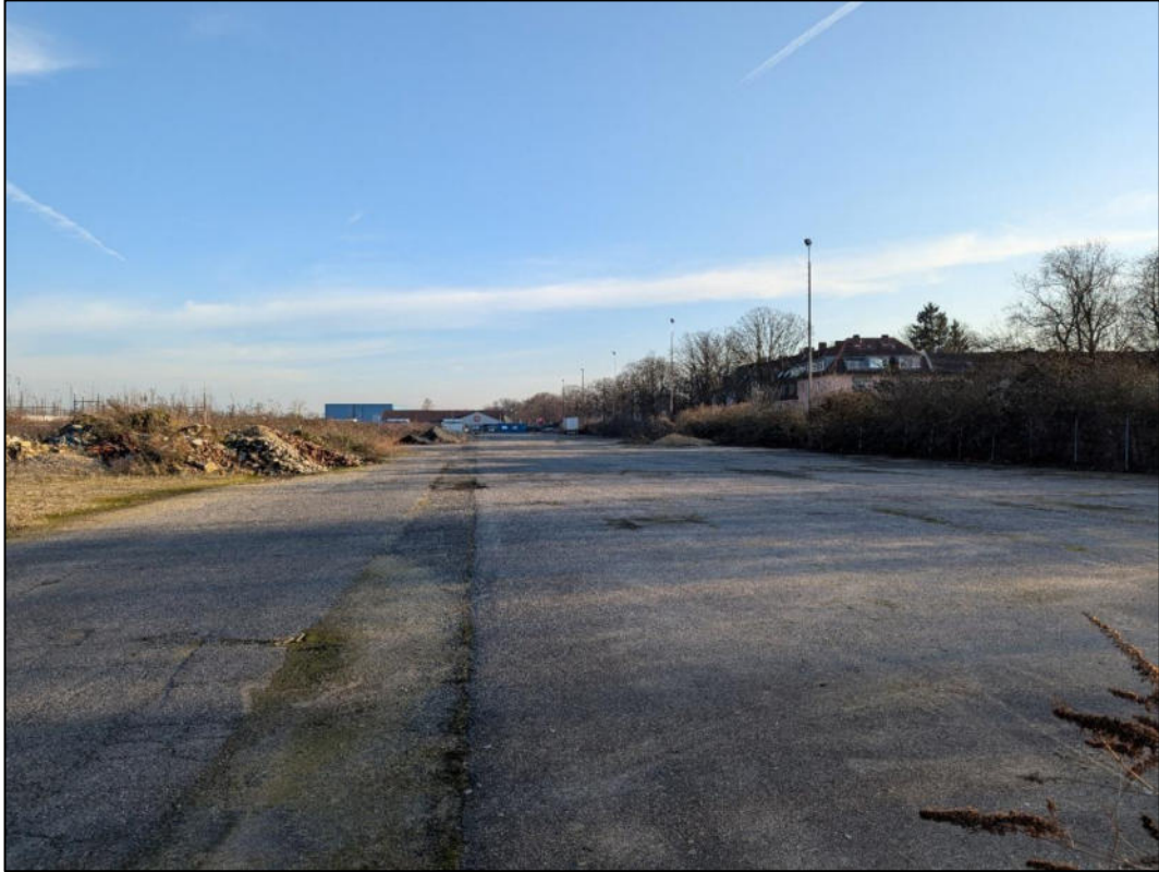
Abb. 5: südlicher, asphaltierter Bereich des Plangebiets. Blickrichtung Süd
