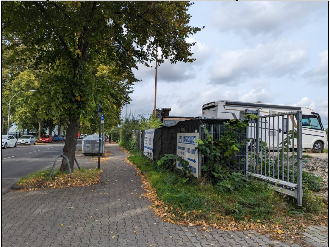
Foto 1: Longericher Straße mit südöstliche Zufahrt zum Plangebiet
