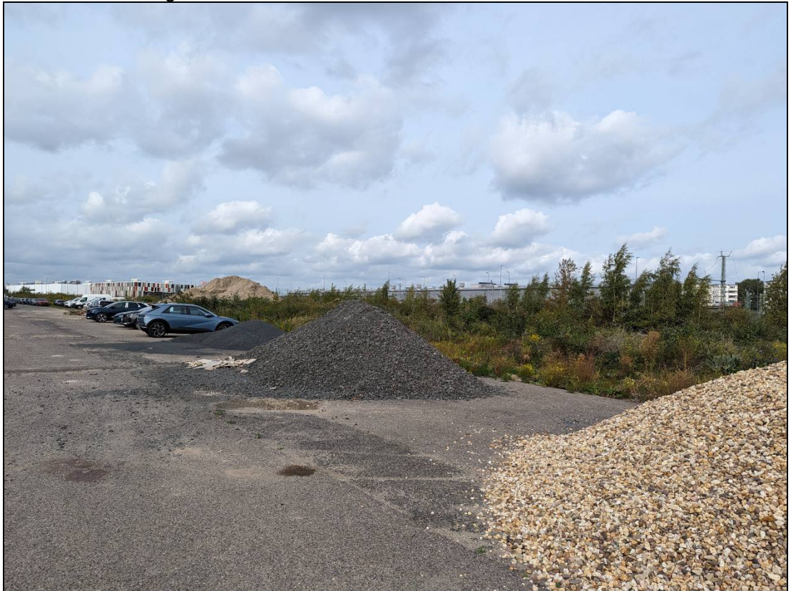
Foto 7: Materiallagerflächen im mittleren Teil des Geländes
