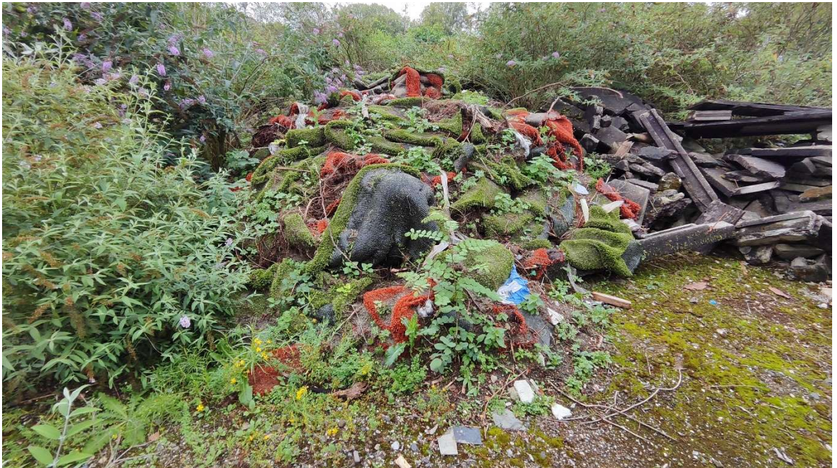
Bild 7-10: Auf dem Baugrundstück gelagerte Störstoffe (Kunstrasen), Betonpfeiler und Altholz
