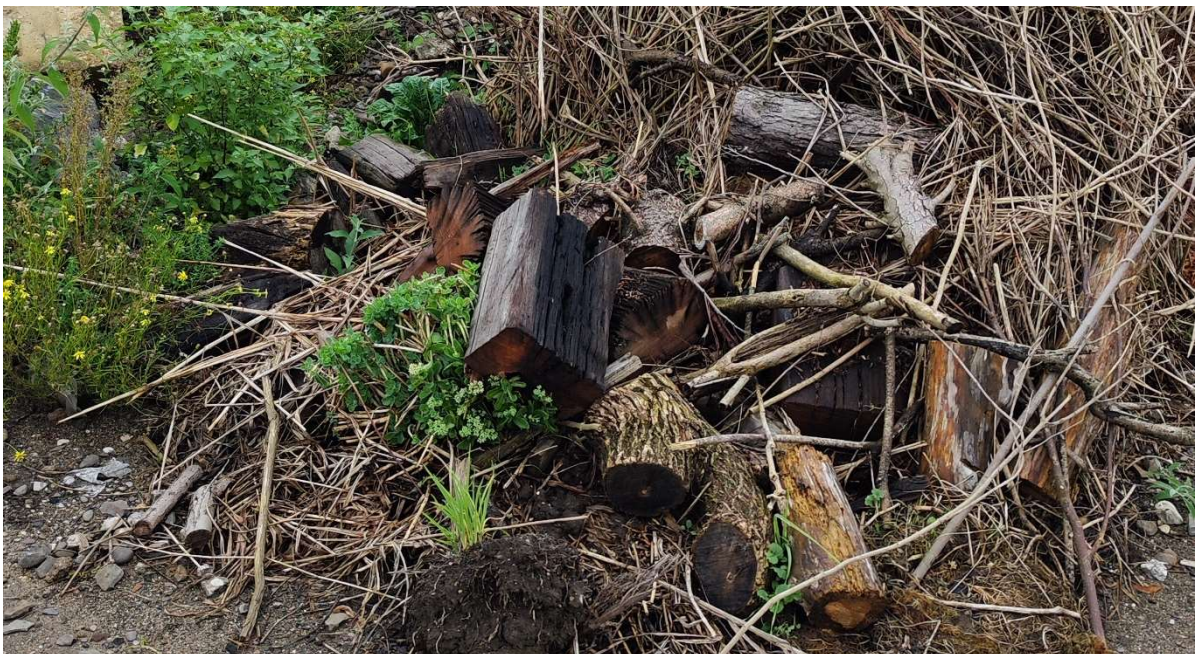
Bild 7-3: Auf dem Baugrundstück abgelagertes Altholz (u.a. Bahnschwellen)
