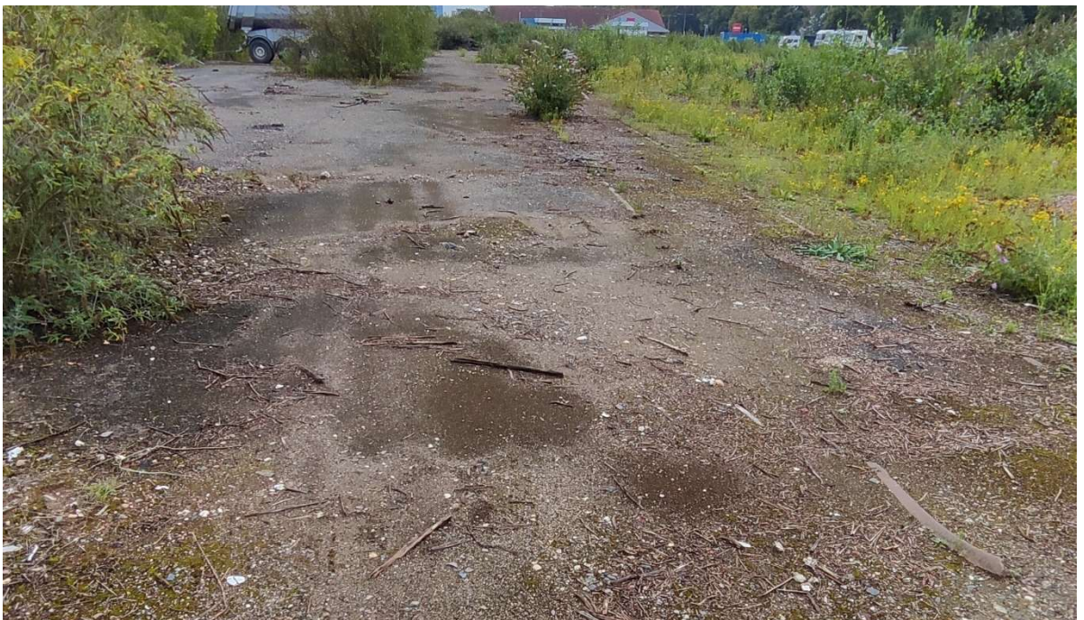
Bild 7-9: Noch vorhandene Gleisanlage und ggf. teerhaltiger Altasphalt
