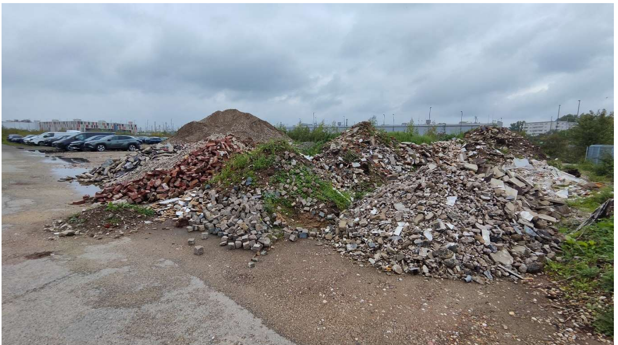
Bild 7-5: Mieten aus Abbruchmaterial, augenscheinlich sortiert nach stofflicher Zusammensetzung (u.a. Beton, Ziegel, Glas, Holz, Metall)
