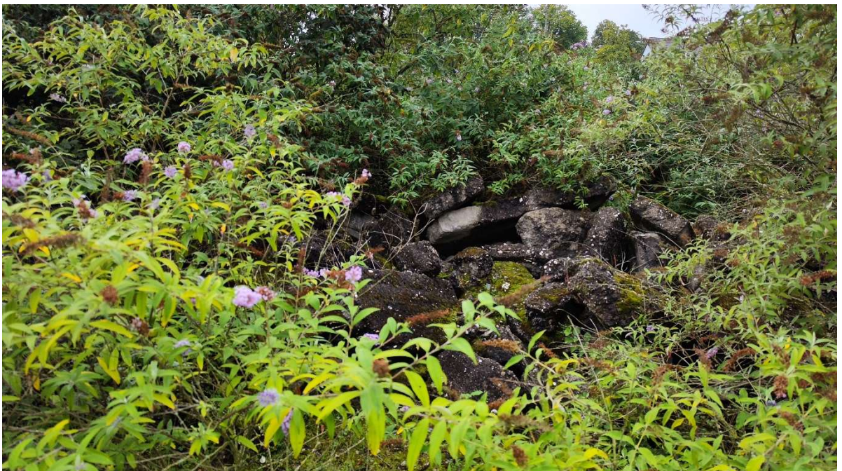
Bild 7-11: Stark zugewachsene Miete aus Altasphalt und Betonbruch, z.T. auch Stahlschrott und Altholz (Bahnschwellen)
