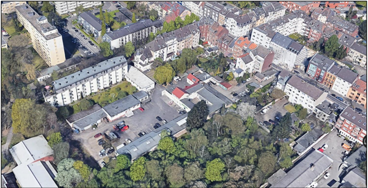
Abbildung 2: Blick auf die Vorhabenfläche und die Umgebung (Quelle: Fa. Projekton).
