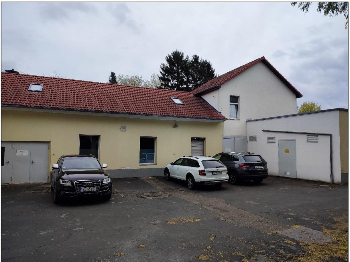
Abbildung 12: Gebäude im Nordosten der Fläche.
