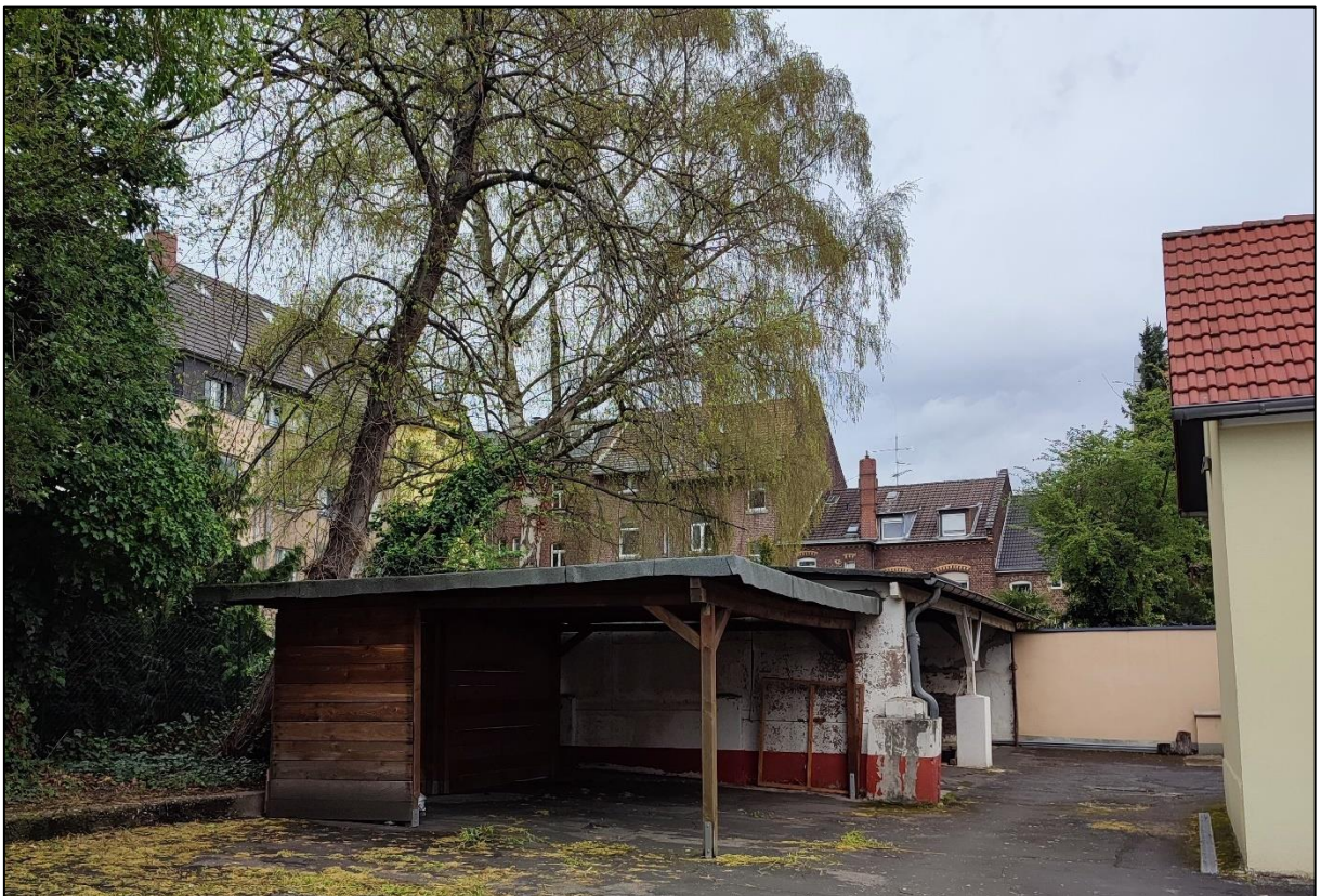
Abbildung 8: Blick auf Garagen ganz im Nordwesten der Vorhabenfläche.
