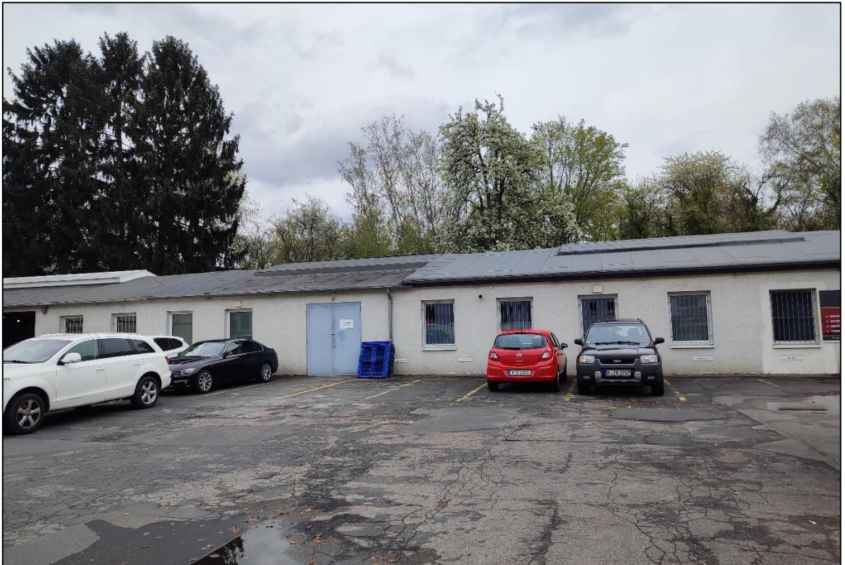
Abbildung 11: Flachbauten im Osten der Fläche.
