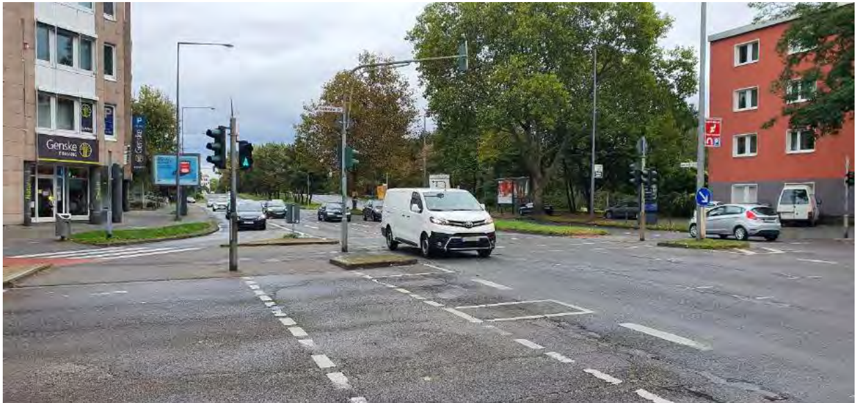
Abbildung 2-3: Knotenpunkt Subbelrather-/ Innere Kanalstr., Blick in Richtung Norden
