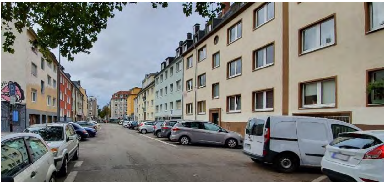
Abbildung 2-12: Franz-Geuer-Str., Blick in Richtung Venloer Str.
