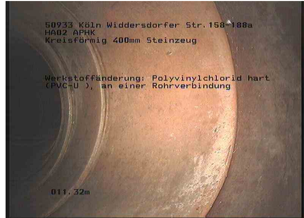
2, 00:01:58, 11.32m Werkstoffänderung: Polyvinylchlorid hart (PVC-U), an einer Rohrverbindung
