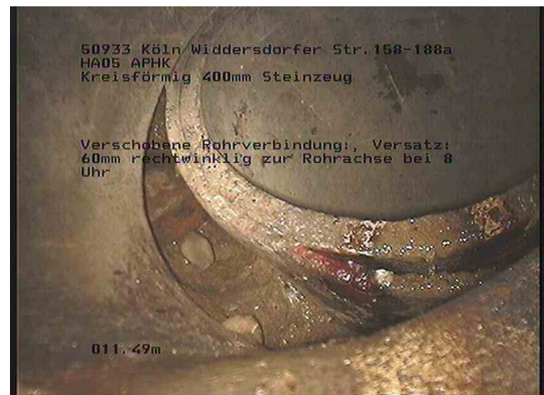
4, 00:02:36, 11.49m Verschobene Rohrverbindung:, Versatz: 60mm rechtwinklig zur Rohrachse bei 8 Uhr
