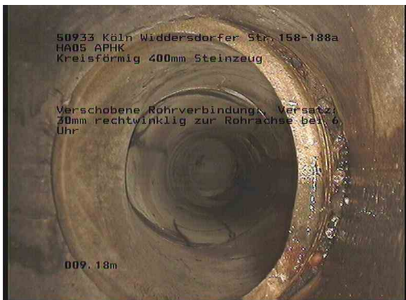
3, 00:01:58, 9.18m Verschobene Rohrverbindung:, Versatz: 30mm rechtwinklig zur Rohrachse bei 6 Uhr
