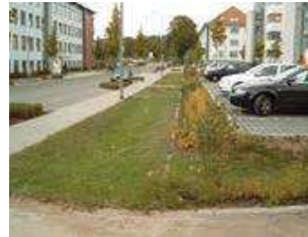
Versickerungsmulde einer Mulden-Rigole nach Fertigstellung
