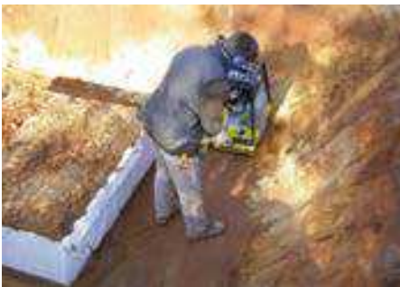
Verdichten des Arbeitsraumes
