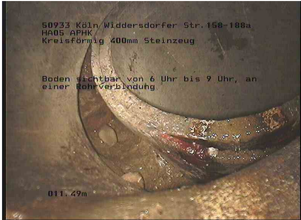
5, 00:02:39, 11.49m Boden sichtbar von 6 Uhr bis 9 Uhr, an einer Rohrverbindung
