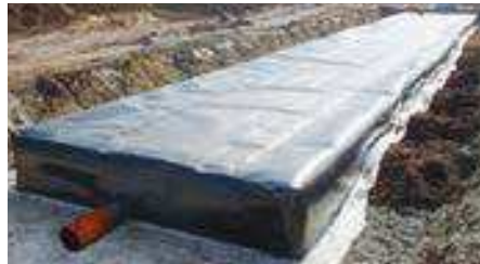
Regenwasserspeicher mit Folienummantelung
