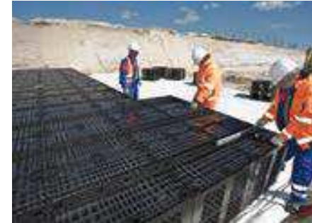
Einbau der RAUSIKKO Boxen
