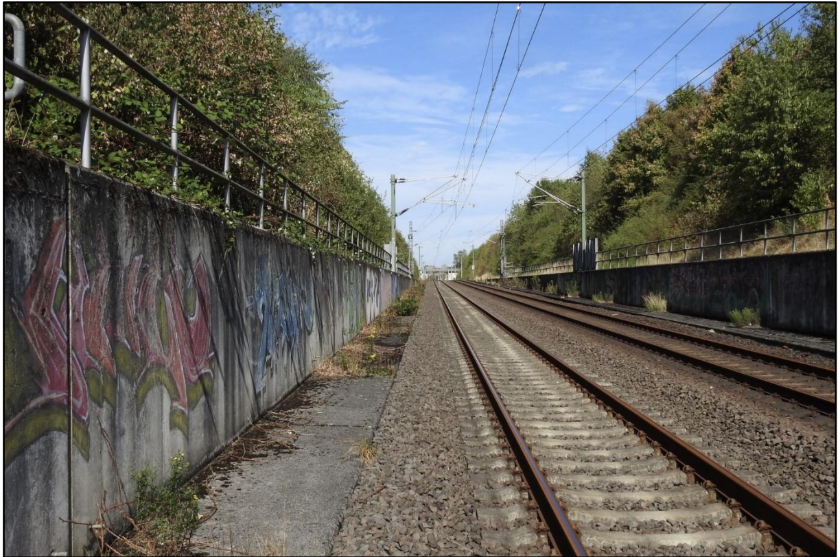
Abbildung 5: Bahntrasse im unmittelbaren östlichen Umfeld des Plangebietes.
