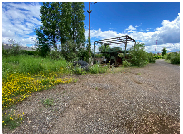
Bild 18: ...und von dort Blick in östlicher Richtung auf ein Bauwerk.
