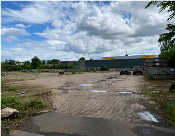
Bild 1: Blick von westlicher Richtung auf das Deutsche Post Logistikzentrum.
