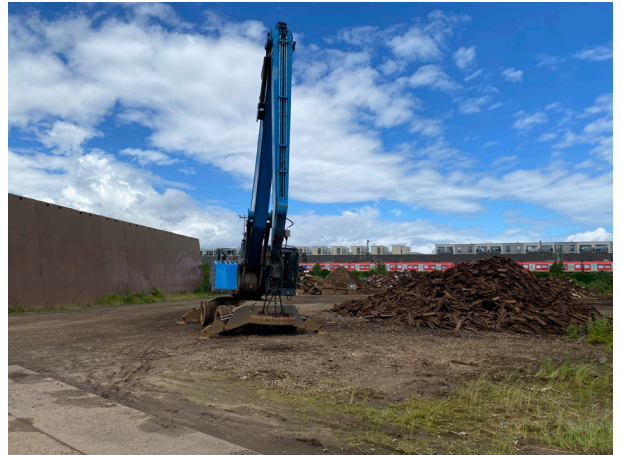
Bild 2: Blick auf Baggerarbeiten und die Ehrenfelder Bahntrasse, die das Areal von nördlicher Seite aus umschließt.
