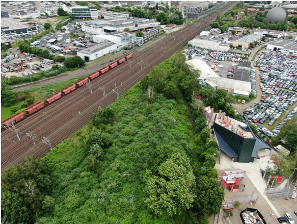
Bild 36: Blick auf den Parkplatz, Gaskugel im Hintergrund.
