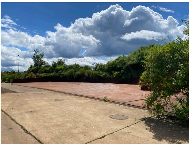
Bild 17: Wendefläche neben der Maschinenhütte...
