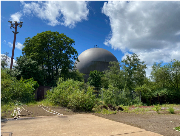
Bild 13: Blick aus nördlicher Richtung auf die ‚Gaskugel‘...
