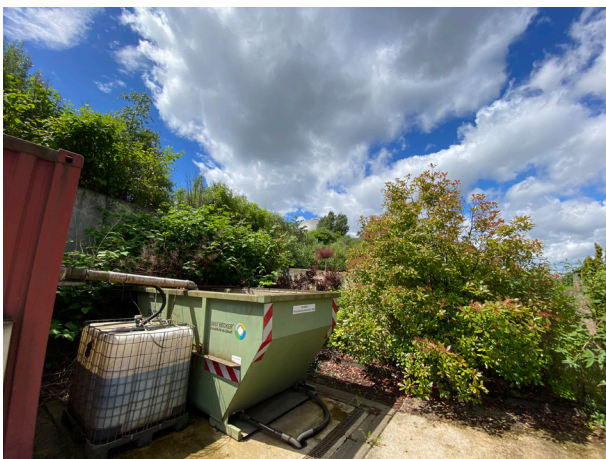
Bild 21: Container östlich der Gaskugel.
