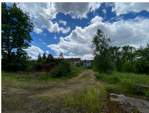
Bild 33: Im Hintergrund sehenswerte Bestandsgebäude, südliches Areal.
