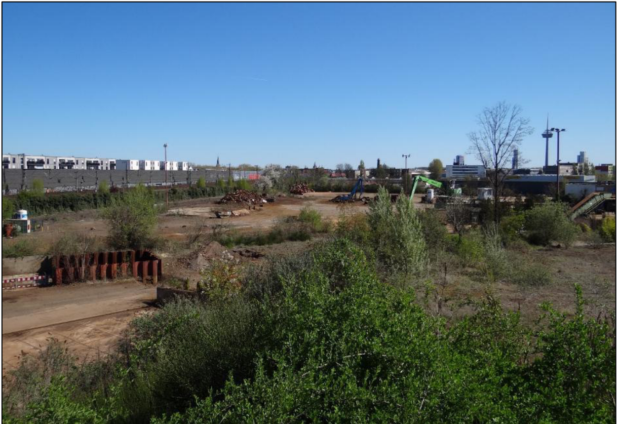
Abbildung 2: Blick über das Betriebsgelände der Firma Max Becker mit Gleisbereichen, Lagerflächen und vereinzelt Aufwuchs von Hochstauden und Gehölzen.
