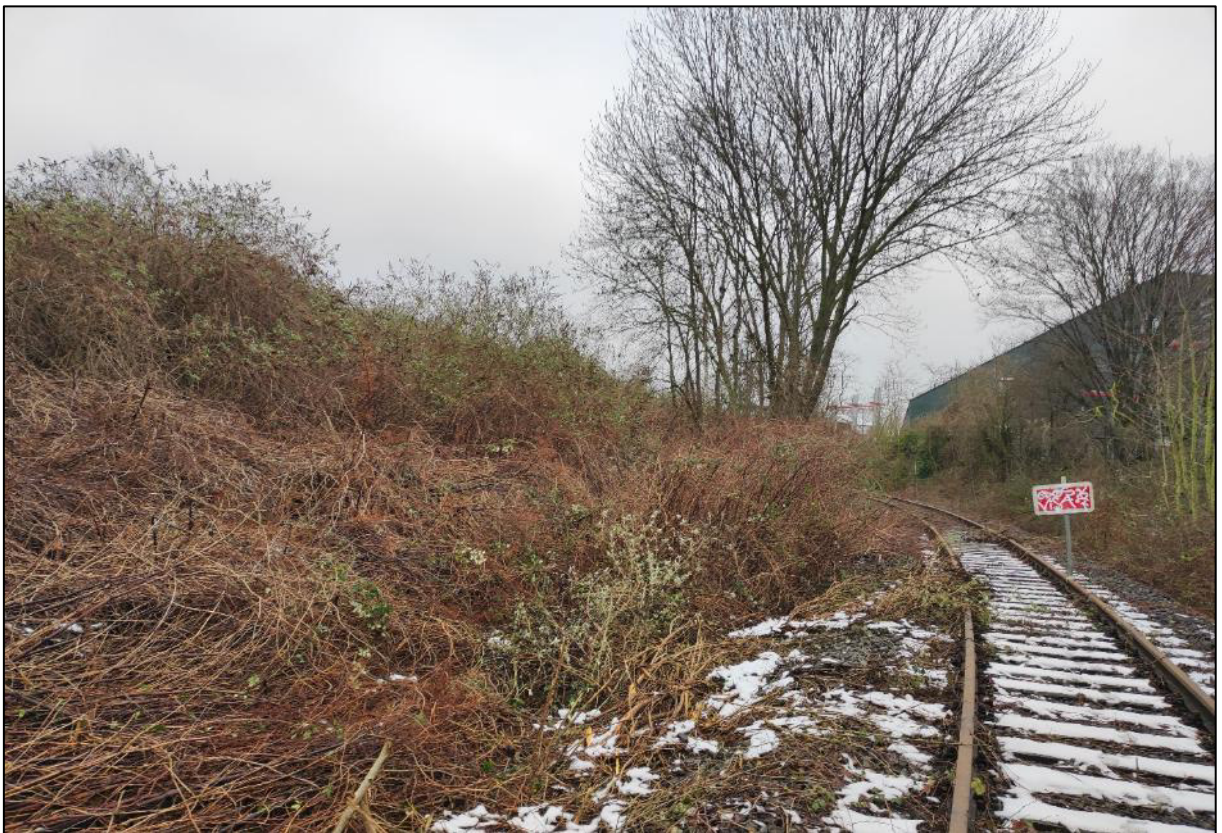
Abbildung 5: Stillgelegte Werksbahntrasse und von Gehölzen bewachsene Gleisharfe im westlichen Plangebiet.
